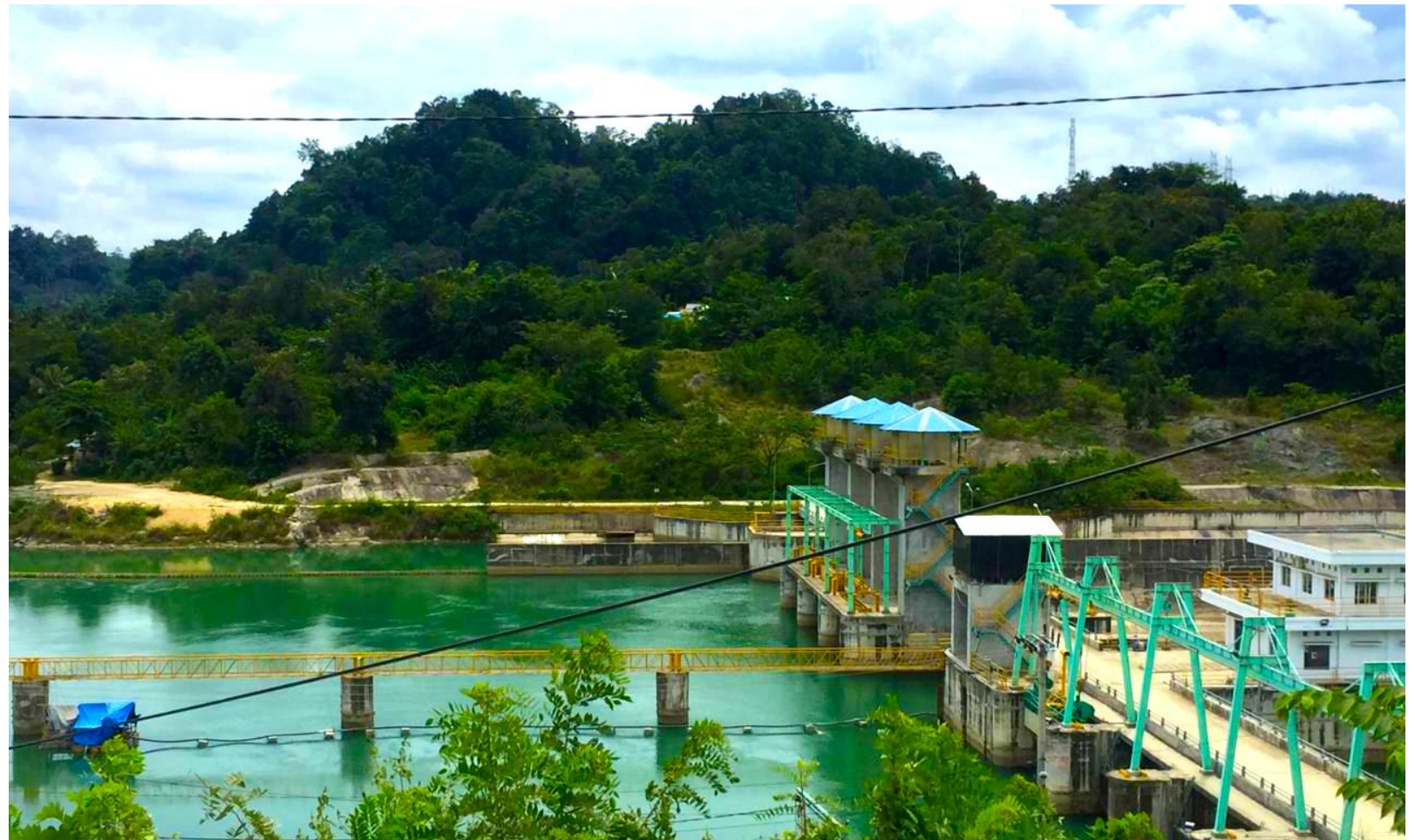
Bendungan Poso Unit 2 di wilayah Sulewana
